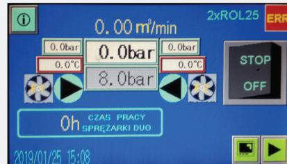
Sprężarki ONE-FU oraz DUO zapewniają **szeroki zakres regulacji obrotów/wydatku**. Zaawansowany i przyjazny użytkownikowi **system sterowania PLC**, oprócz podstawowych informacji o temperaturze, ciśnieniach, poziomie oleju i czasie pracy, pokazuje również aktualny wydatek powietrza.
